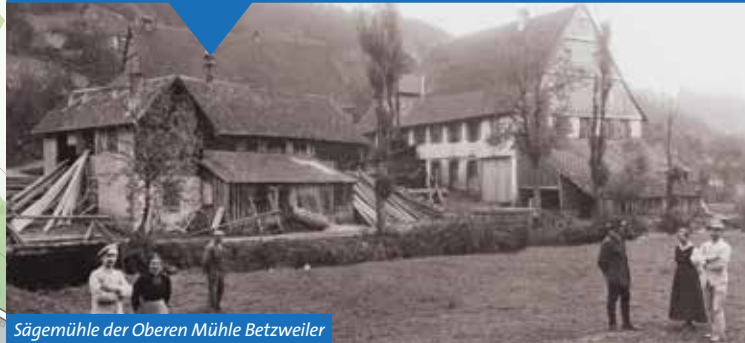
Sägemühle der Oberen Mühle Betzweiler
